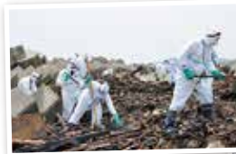
◎除染作業の様子
