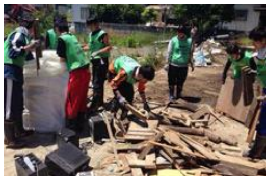
家を撤去する様子
