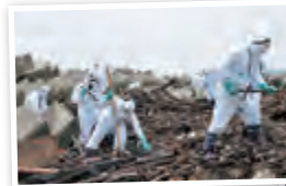
◎除染作業の様子
